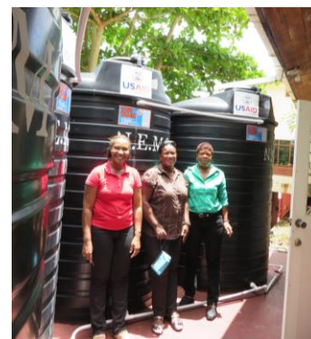
Los tanques ofrecen una fuente segura de agua potable para los ocupantes de los albergues.
