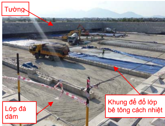
Nền móng của kết cấu móng
